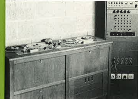
Nationaltheater Mannheim, Umschnittsraum, links VOLLMER MTG 9/57 W und rechts VOLLMER-Studio-Maschine, geliefert im Jahre 1947, erste Magnettonmaschine in einem deutschen Theater
